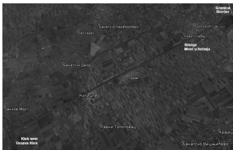
Слика 23. Траса саобраћајнице по насипу од границе са Румунијом до уставе Клек
