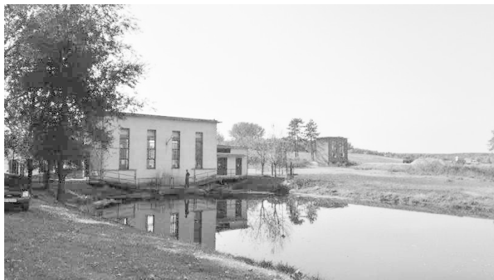
Сл. 4 Објекат црпне станице на месту уливања канала Татарница
