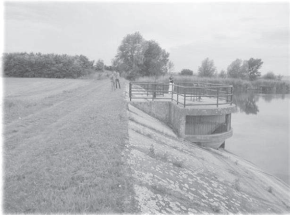
Слика 9: Објекат на акумулацији Чонопља, преливни орган
