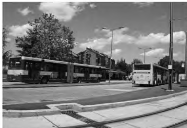
Слика 59. Терминус „Баново брдо“
