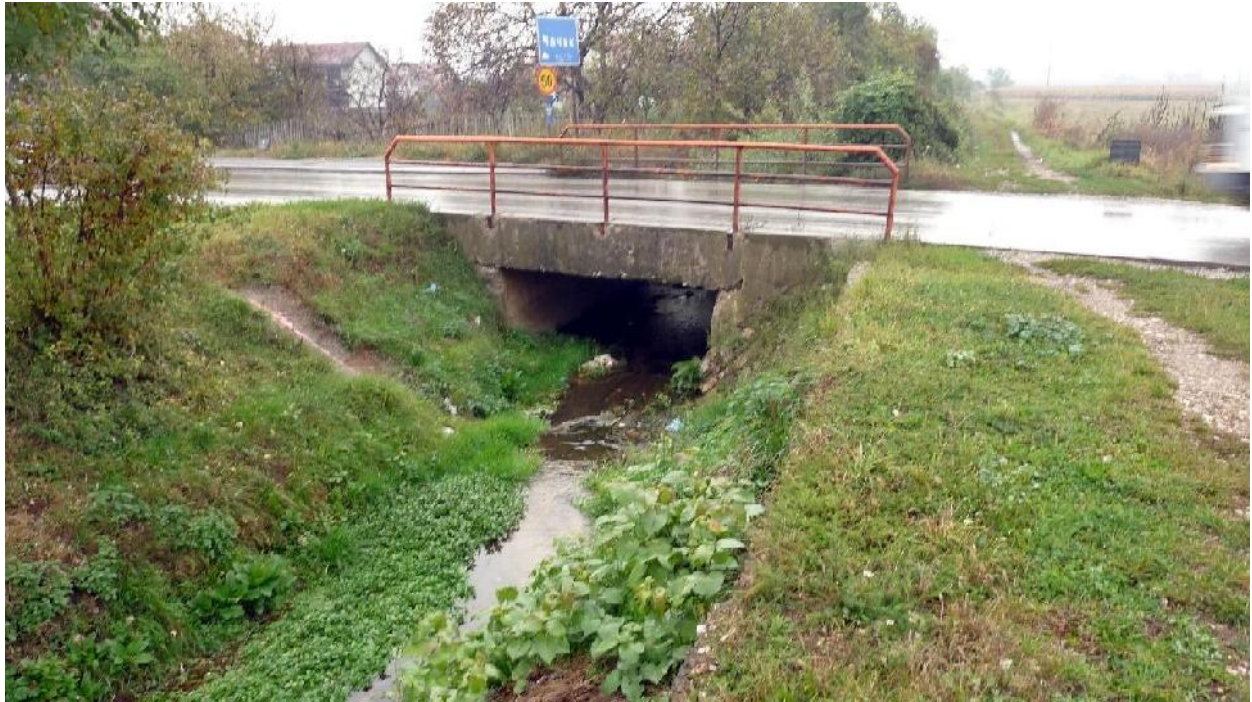
Слика 12. Трнавска река ID:RPMTr4 (смањени протицајни профил плочастог пропуста)
