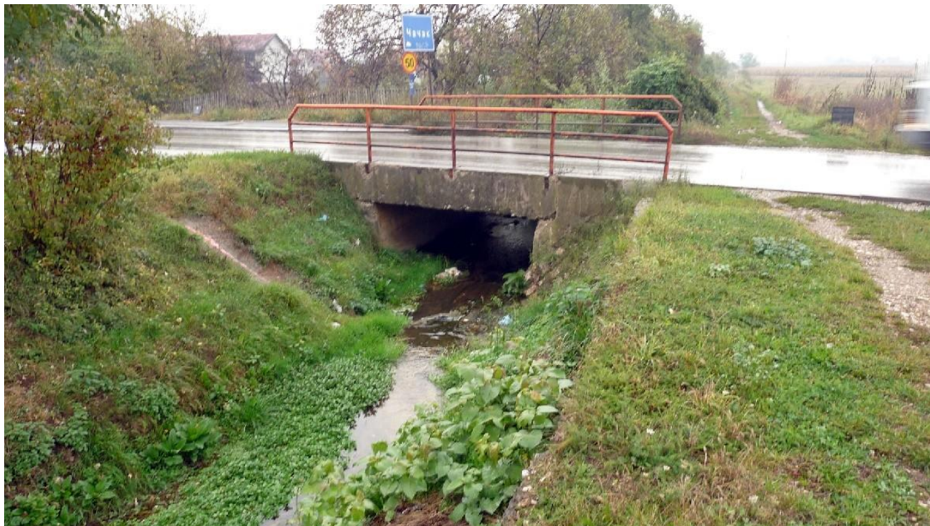
Слика 12. Трнавска река ID:RPMТр4 (смањени протицајни профил плочастог пропуста)
