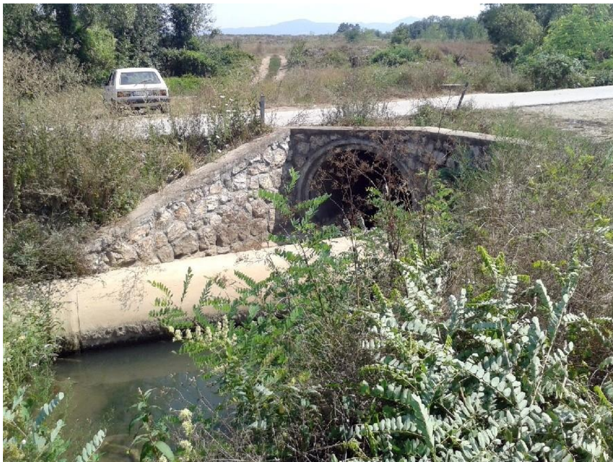
Слика 11. Атеничка река ID:RPMAt1 (Канализациони колектор који се налази у кориту водотока , заједно са пропустом недовољног пречника. Најнизводнији пропуст)
