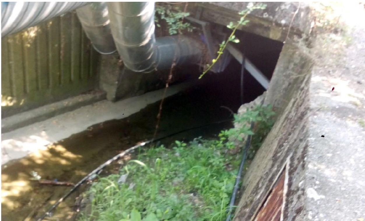
Слика 10. Лозничка река ID:RPMLo7 (смајњен протицајни профил усле
