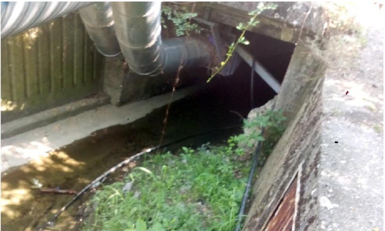
Слика 10. Лозничка река ID:RPMLo7 (смањен протицајни профил услед објекта у кориту)
