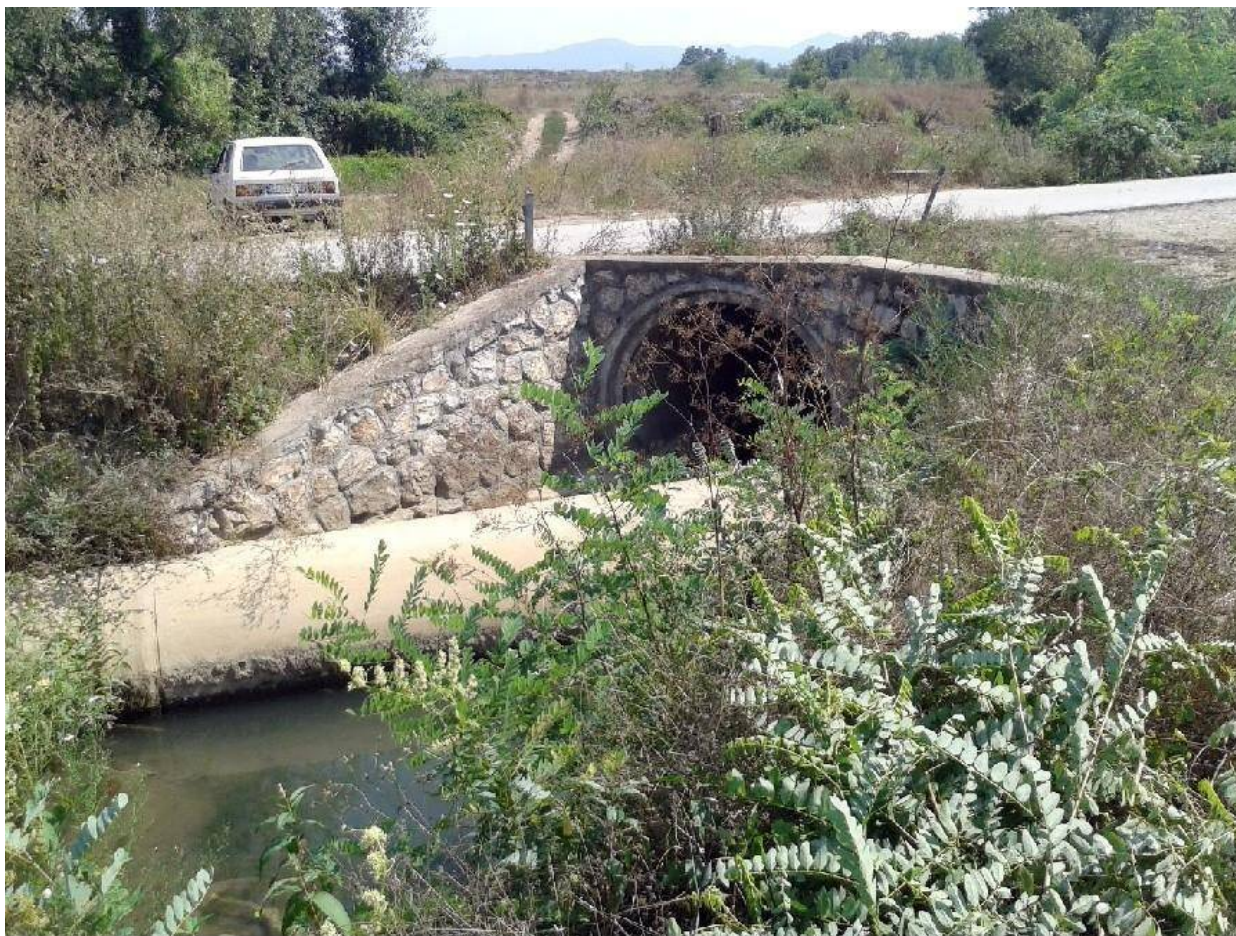
Слика 11. Атеничка река ID:RPMAt1 (Канализациони колектор који се налази у кориту водотока , заједно са пропустом недовољног пречника. Најнизоводнији пропуст)
