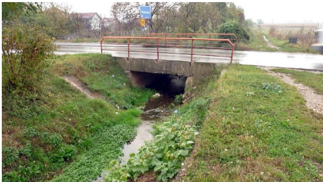
Слика 12. Трнавска река ID:RPMTr4 (смањени протицајни профил плочастог пропуста)
