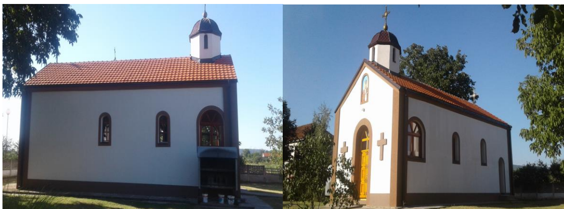
Слика 17 - Црква Св. Никола у Пуковцу (након завршетка радова) Извор: Општинска управа
