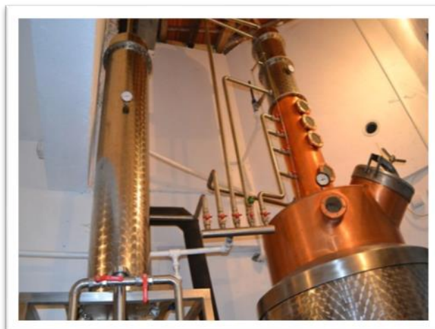
Слика 41 – Дестилерија винског подрума „Живковић“ Извор: Општинска управа
