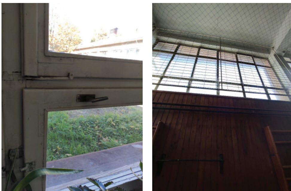
Слика 23. Спољашњи прозори објекта на к.п. 4829 и 4819
