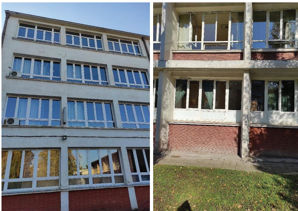
Слика 19. Изглед спољних зидова објекта Главне зграде на К.П. бр. 4828
