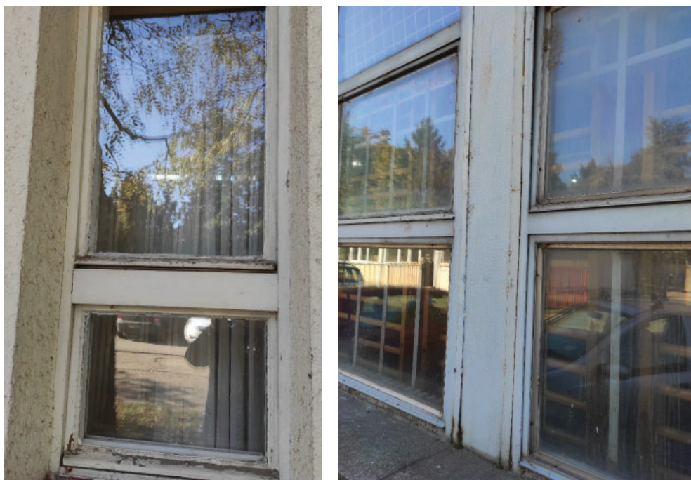
Слика 22. Спољашњи прозори објекта на к.п. 4829 и 4819
