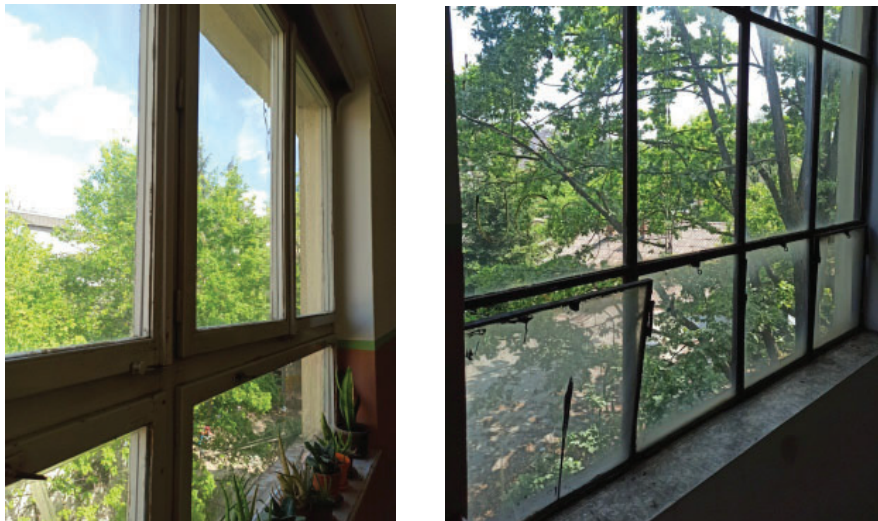
Слика 8. Детаљ дрвених прозора (лево) и Детаљ металних прозора (десно)
