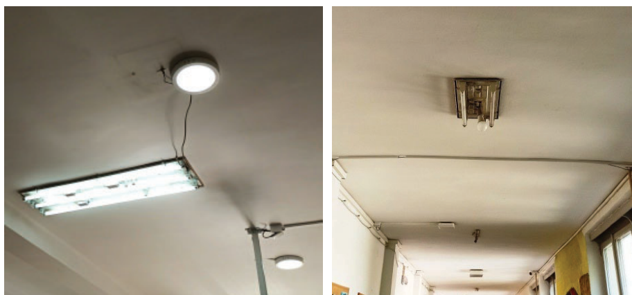
Слика 11. Типови заступљене расвете - комбинација флуоресцентног осветљења и новоуграђених ЛЕД светилки
