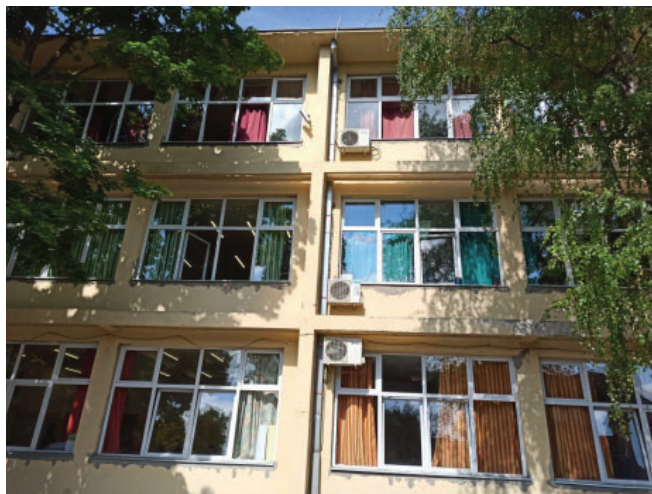
Слика 6. Изглед спољних зидова и новоуграђених ПВЦ прозора главне зграде са западне стране
