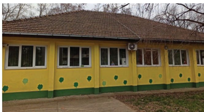
Слика 6. Изглед спољних зидова и новоуграђених ПВЦ прозора објекта са северне стране
