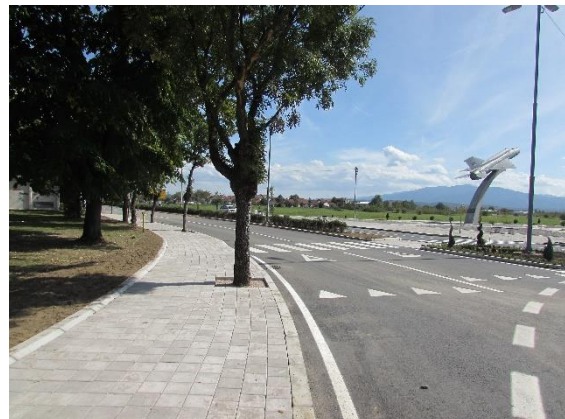
Реконструкција раскрснице Ул. Бруски пут и Ул. Кнеза Милоша
