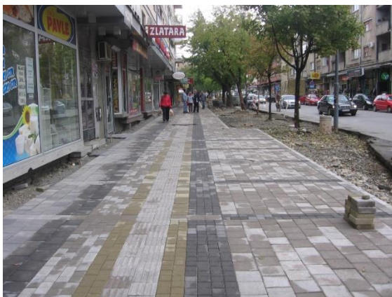
Тротоари у Ул.Видовданској током реконструкције (2015.година)
