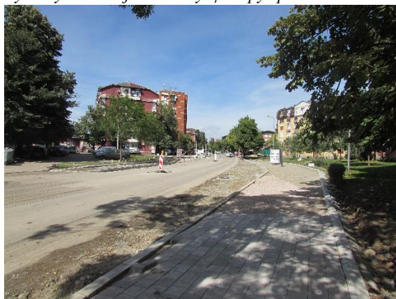
Изградња аутобуских ниша у Ул.Бруски пут
