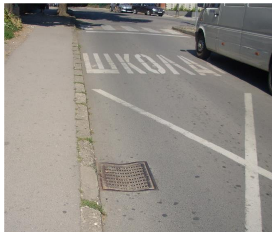
Ул. Владетина (правац пружања отвора на поклопцу атмосферске канализације је супротан смеру кретања)
