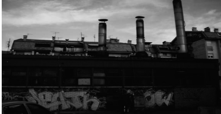
Слика 4.10. Котларница Папазовац
