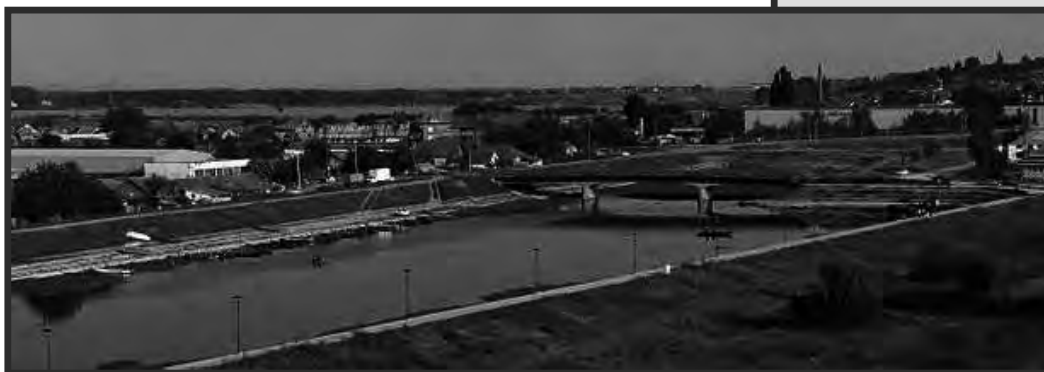
Слика бр.87 Поглед на Језаву са Смедеревске тврђаве
