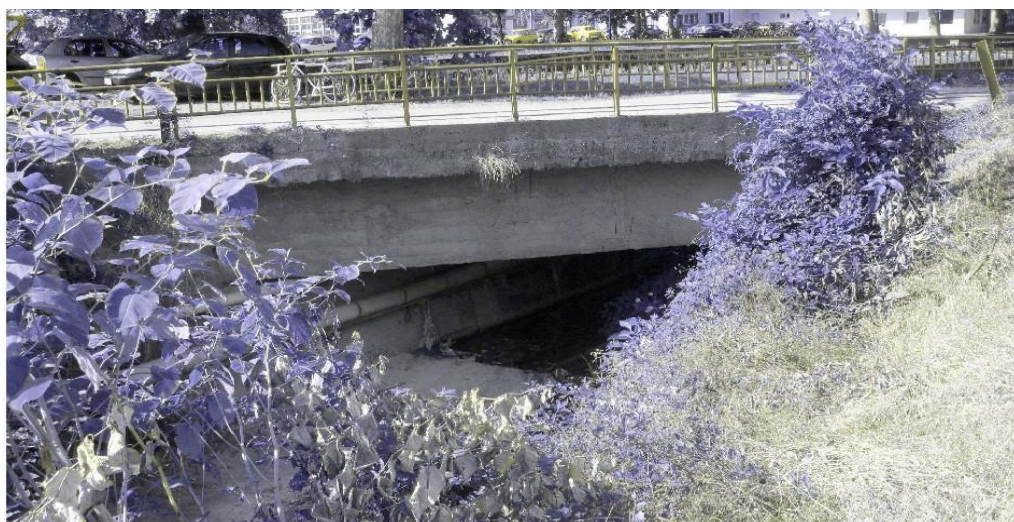
Слика 9. Јездинска Лупњача, пропуст ID:RPM Lu5 (недовољан протицајни профил мостовског пропуста)
