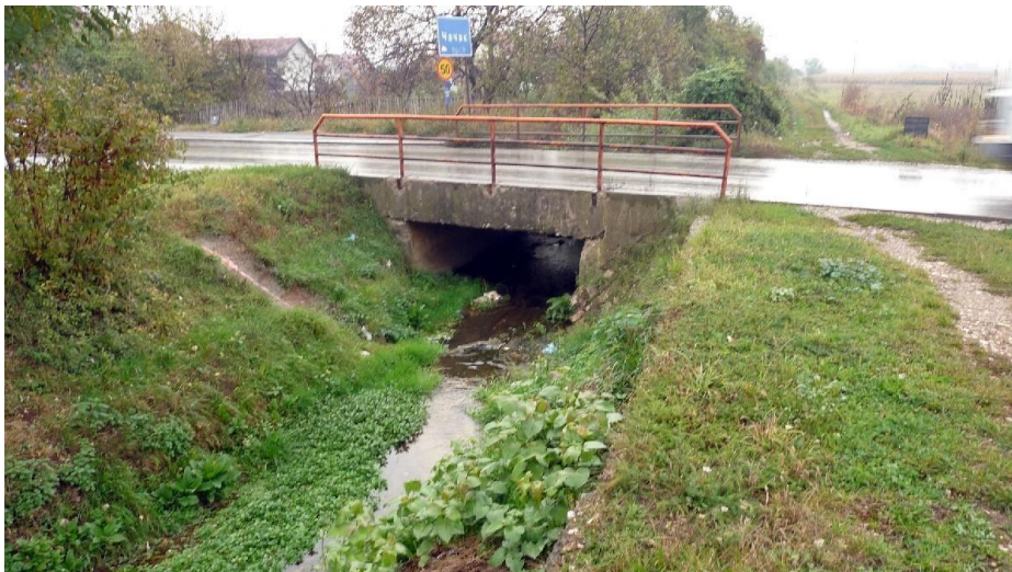
Слика 13. Трнавска река ID:RPMТр4 (смањени протицајни профил плочастог пропуста)
