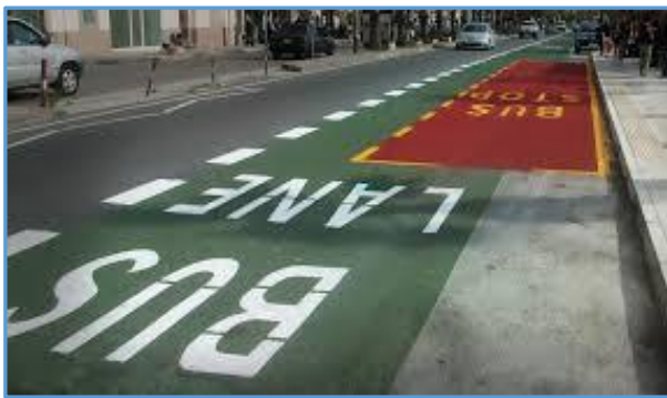
Слика 4.6 Приказ могућих начина означавања посебних саобраћајних трака за возила ЈП на прилазима раскрсници
