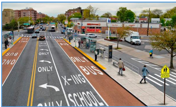
Слика 4.6 Приказ могућих начина означавања посебних саобраћајних трака за возила ЈП на прилазима раскрсници
