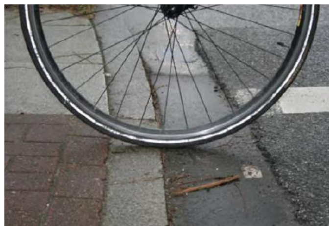
Слика 6-10 Приказ ивичњака са уједначеним прелазом између бициклическе стазе и коловоза
