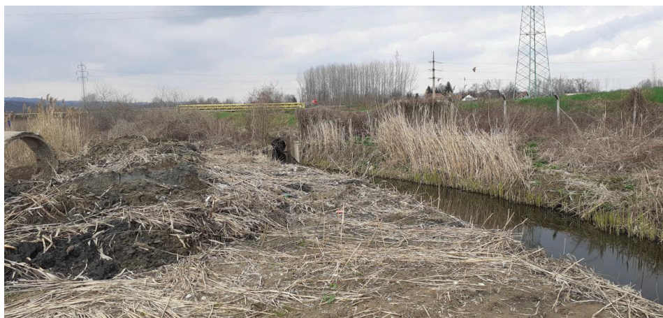
Слика 4.11 - Канал поред депоније за процедурне и отпадне воде
