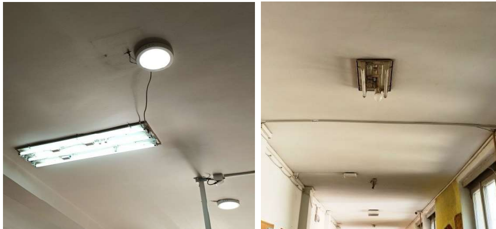
Слика 11. Типови заступљене расвете - комбинација флуоресцентног осветљења и новоуграђених ЛЕД светиљки
