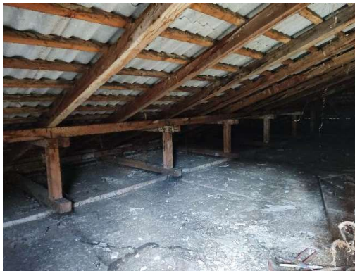
Слика 0.2 - Кровна и међуспратна конструкција (таваница)
