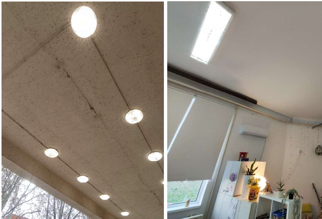
Слика 0.6 – LED расвета уграђена у објекту
