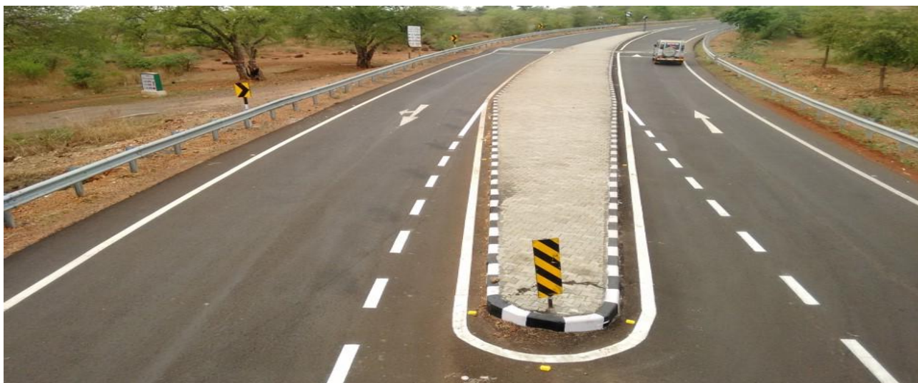
Слика 31 Формирање физички раздвојених коловозних трака са једном саобраћајном траком 6
