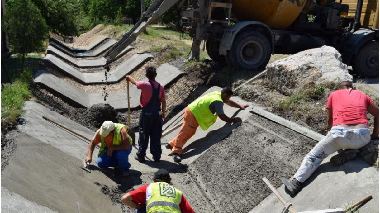
Слика бр 9: Бетонирање јаруге Јун 2015, Насеље Подлив, Град Зајечар; Извор: zajecar.info
